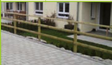
Pfähle KDI\* zylindrisch gefräst, Kopfende gefast
