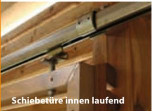
**Gleitbeschlag mit Alurahmen 300400 ST Innenansicht**
